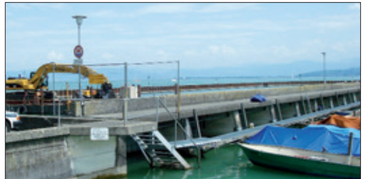
Hinter der alten Mole im Schlosshafen Arbon entsteht bereits die Spundwand für das Gießen der neuen. Später wird die alte abgerissen und die Größe der Anlage sichtbar.
