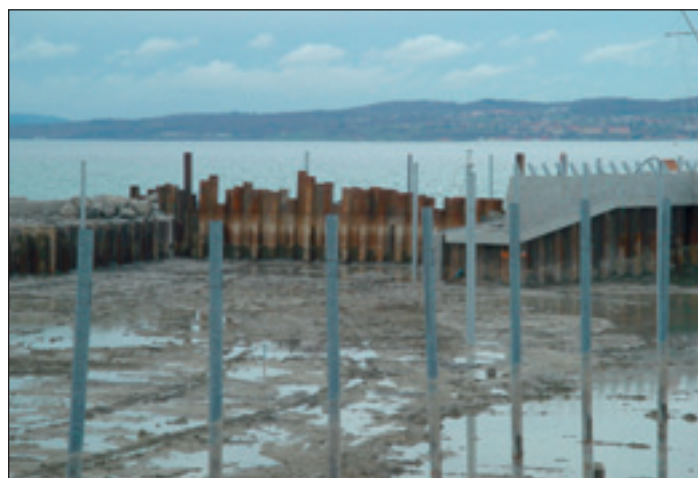
Noch ist die Spundwand drin und der Altnauer Hafen trocken. Kurz nachdem unser Redaktionsmitglied Franco Lamberti das Foto machte, wurde das Hafenbecken mit rund 17.000 Kubikmeter Seewasser geflutet.
